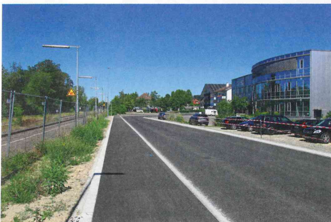
Ende gut, alles gut. Fehlen nur noch die Feinarbeiten wie etwa eine Abgrenzung zu den Gleisen oder die finale Anlage des Grünstreifens.
