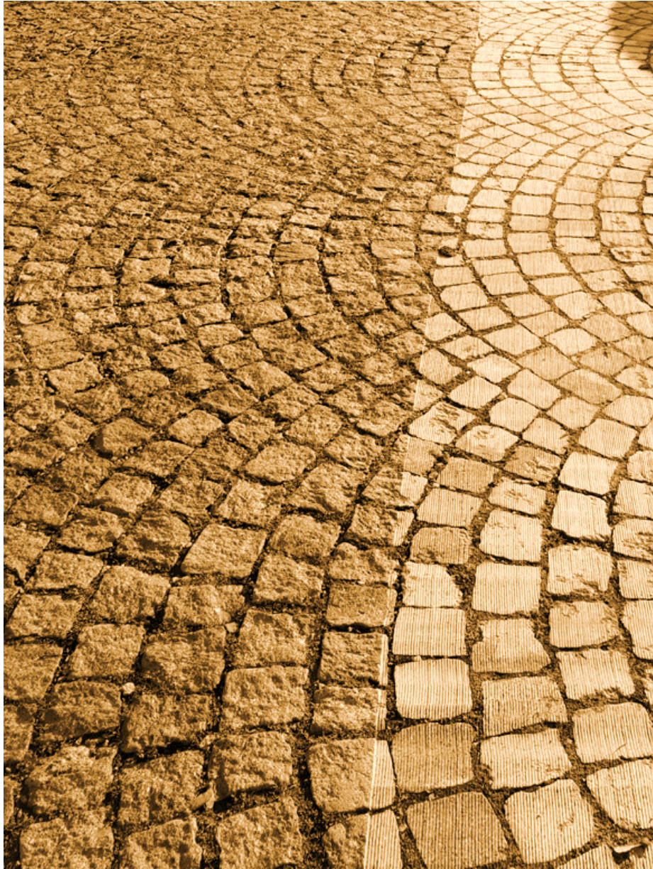
Variante 6 – Bestehendes Natursteinpflaster, geschliffen
