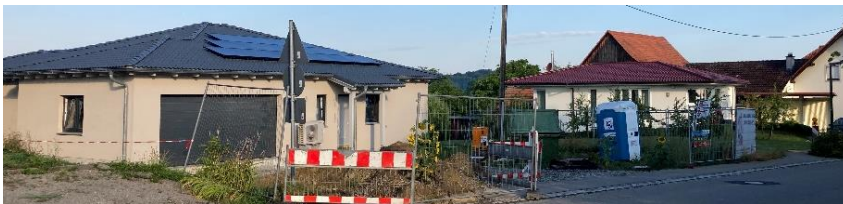
Lückenschließung und Altbestand Kippenhauserstraße
