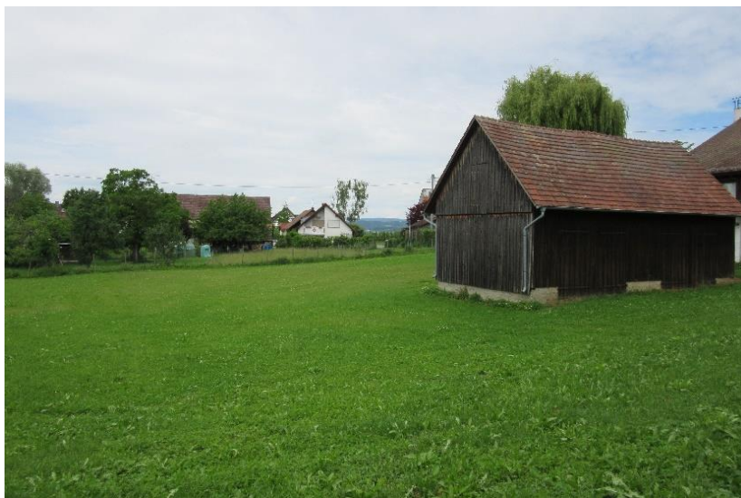
Abbildung 5: Bestandsscheune und Freifläche Bestand, Ansicht von Süden
