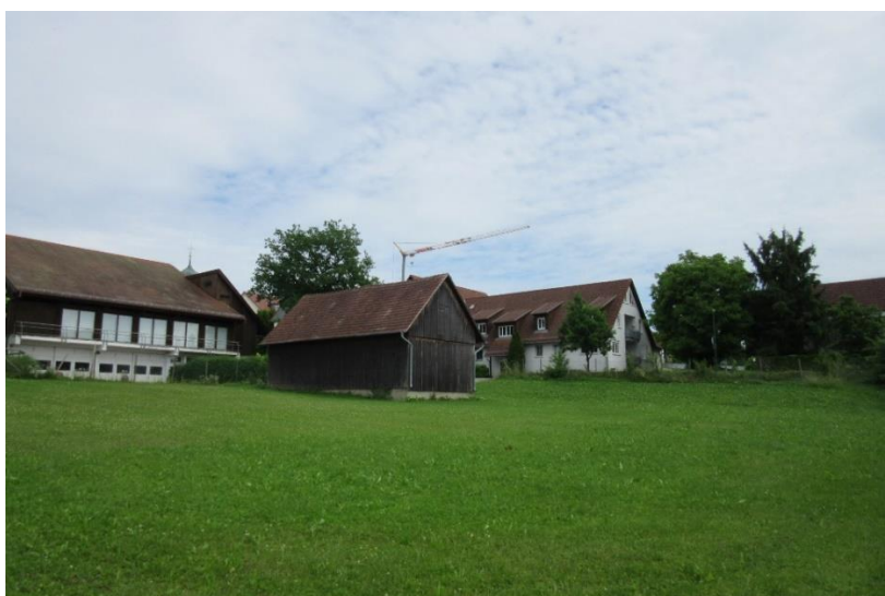
Abbildung 6: Bestandsscheune und Freifläche Bestand, Ansicht von Nord-West
