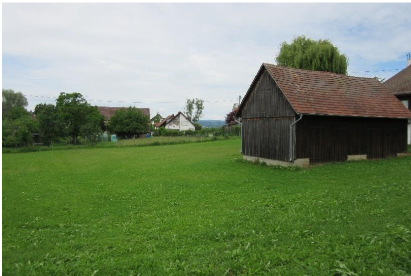
Abbildung 5: Bestandsscheune und Freifläche Bestand, Ansicht von Süden
