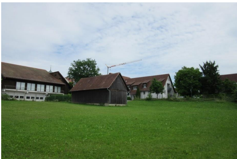
Abbildung 6: Bestandsscheune und Freifläche Bestand, Ansicht von Nord-West
