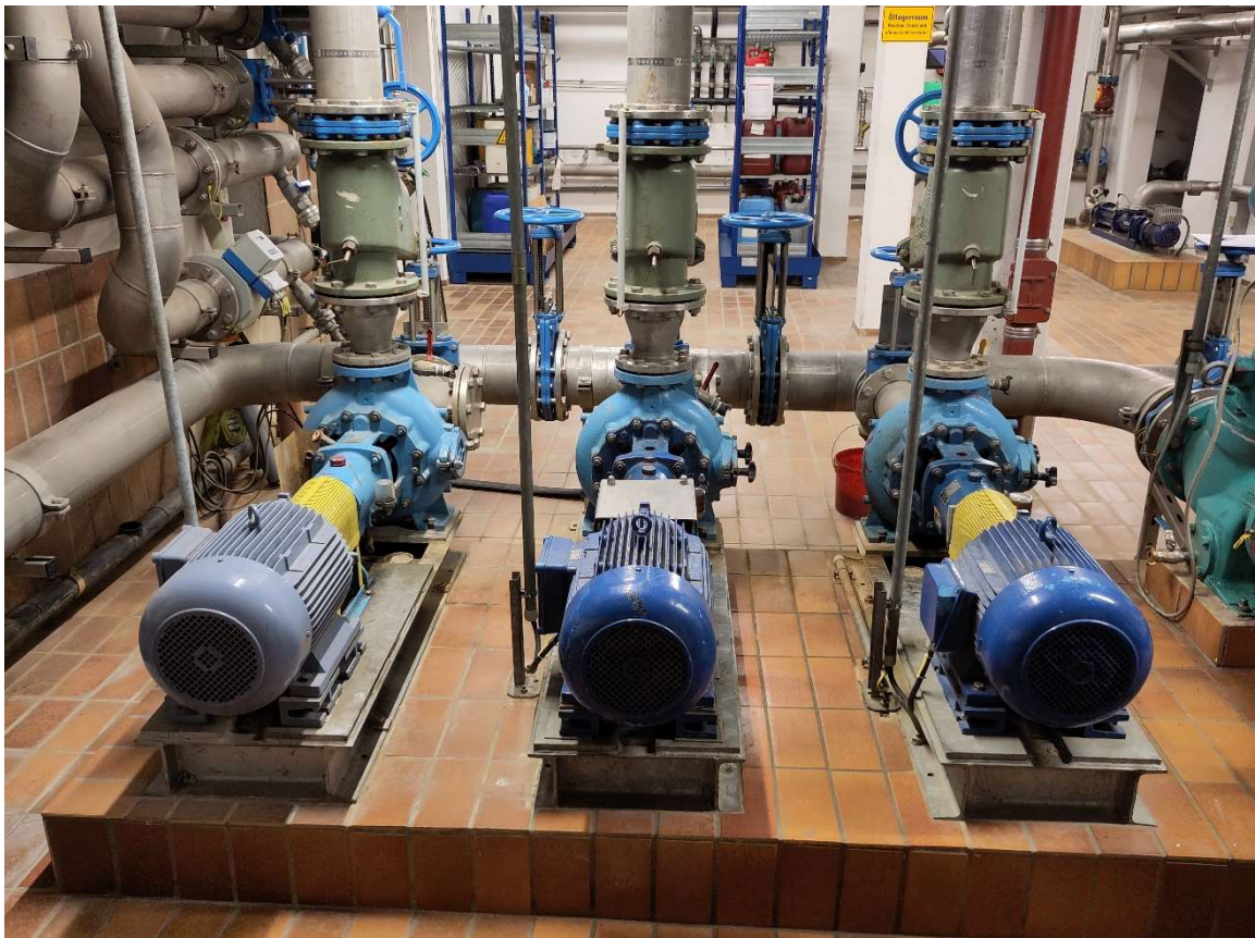
Abbildung 1: Umwälzpumpen Faulung
