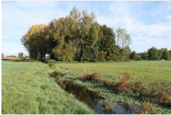
Auch hier ist der Graben bis Oberkante eingestaut Blick nach Nordwesten
