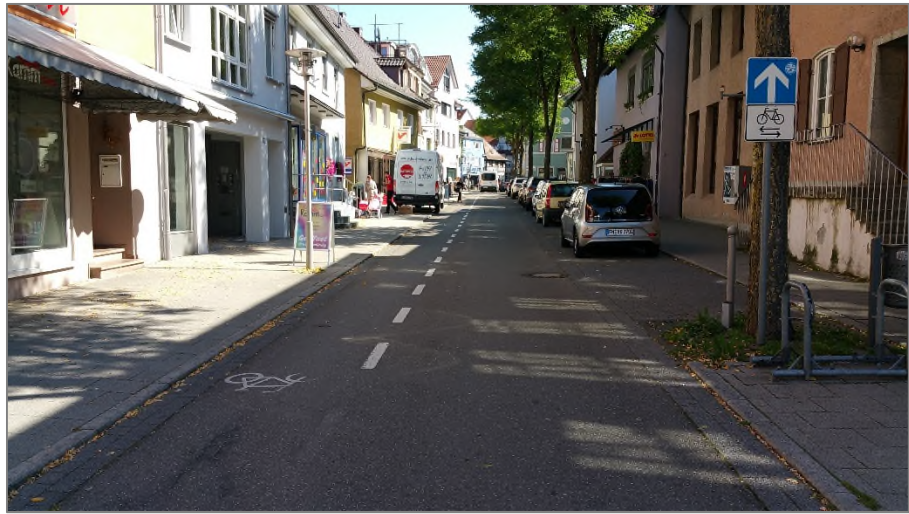
Abb. 1-1: Radfahren in Markdorf, Schutzstreifen in der Hauptstraße
