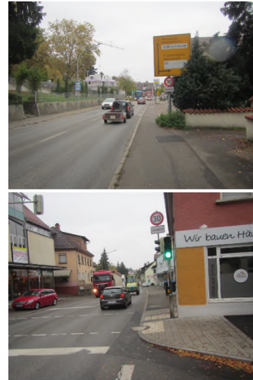
Abb. 6-9: Maßnahmenkataster zu einer Ausbaumaßnahme (STR_166)
